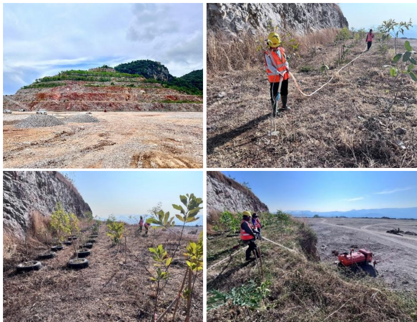
ภาพที่ 1 แสดงงานปลูกและบำรุงรักษาต้นไม้ปลูกใหม่พื้นที่บริเวณเหมืองหินปูน
